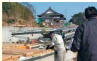
損害調査の様子
